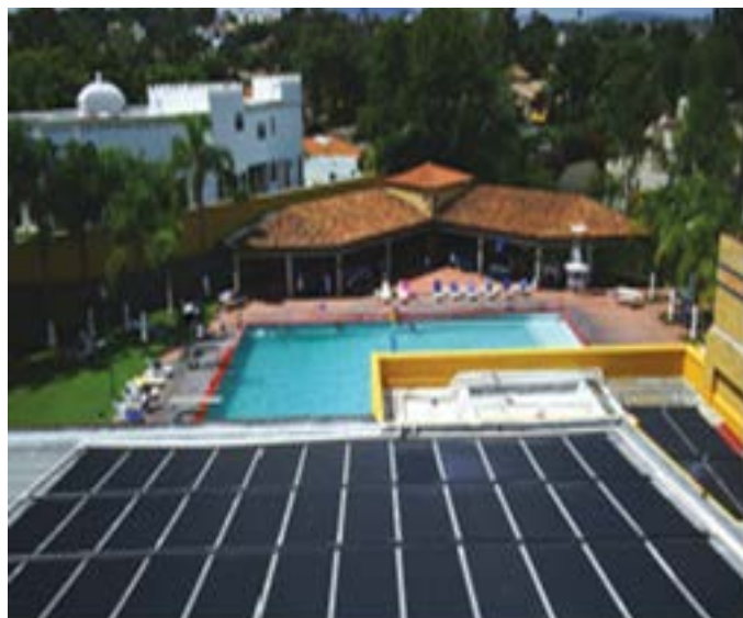
Fig 3.9 Instalaciones de sistemas solares para piscinas.
