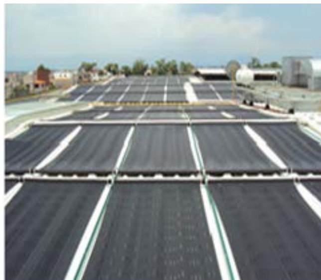
Fig 3.9 Instalaciones de sistemas solares para piscinas.
