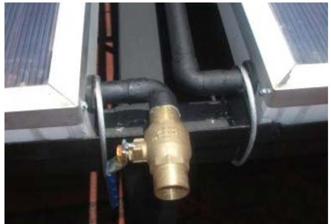
Figura 4.9 Válvula de drenaje o drenado
