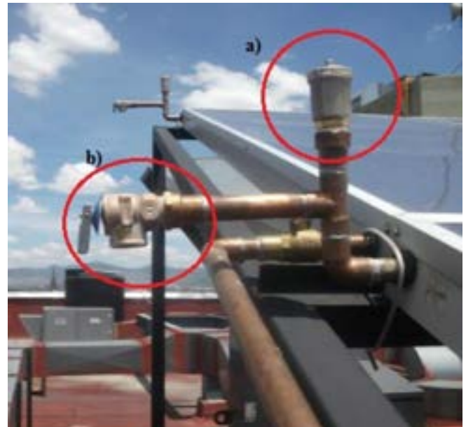
Figura 4.9 Válvula de drenaje o drenado
