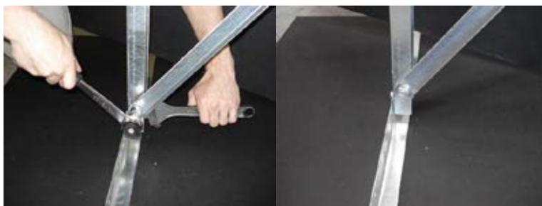
**Ilustración 50. Montaje sobre cubierta plana (6) captadores plano**
