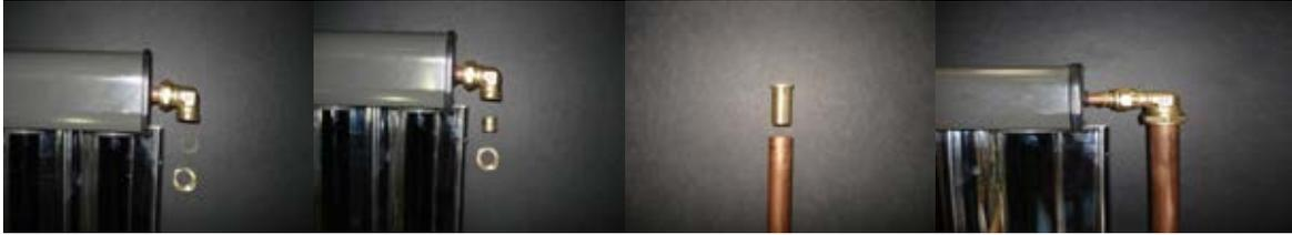
**Ilustración 74. Conexión hidráulica entre captadores CPC (4)**
