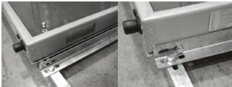
**Ilustración 59. Montaje sobre cubierta inclinada (5) captadores plano**
