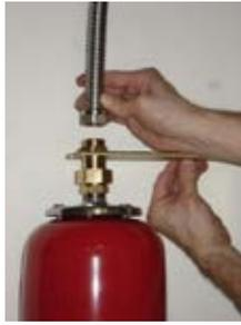
**Ilustración 82. Montaje de vaso de expansión (2)**
