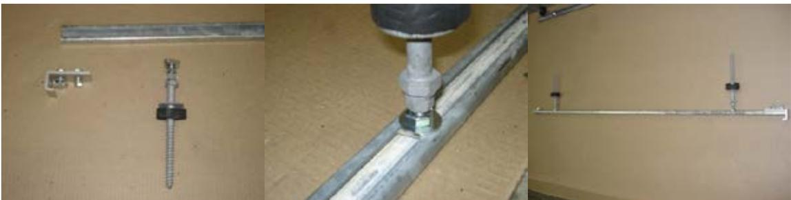
**Ilustración 42. Montaje sobre cubierta inclinada (6) captadores CPC**
