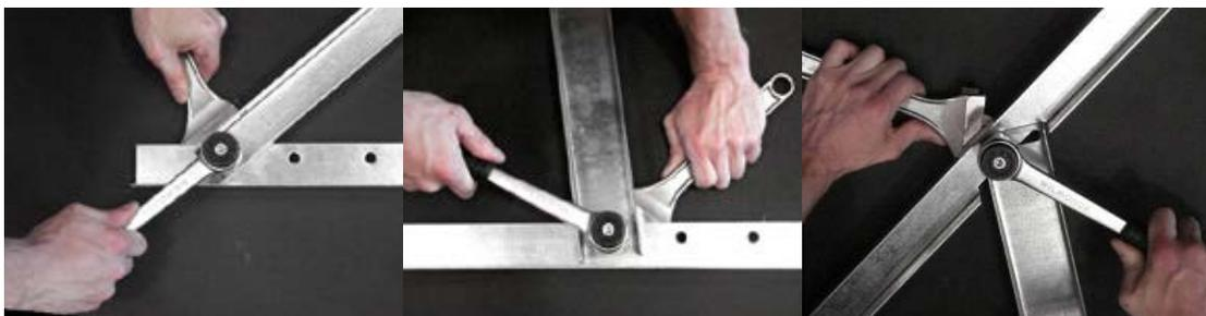
**Ilustración 47. Montaje sobre cubierta plana (3) captadores plano**
