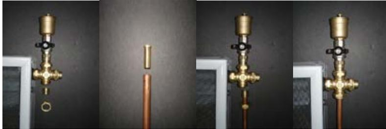
**Ilustración 68. Conexión hidráulica entre captadores planos (5)**
