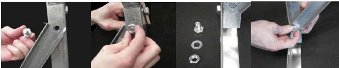
**Ilustración 48. Montaje sobre cubierta plana (4) captadores plano**
