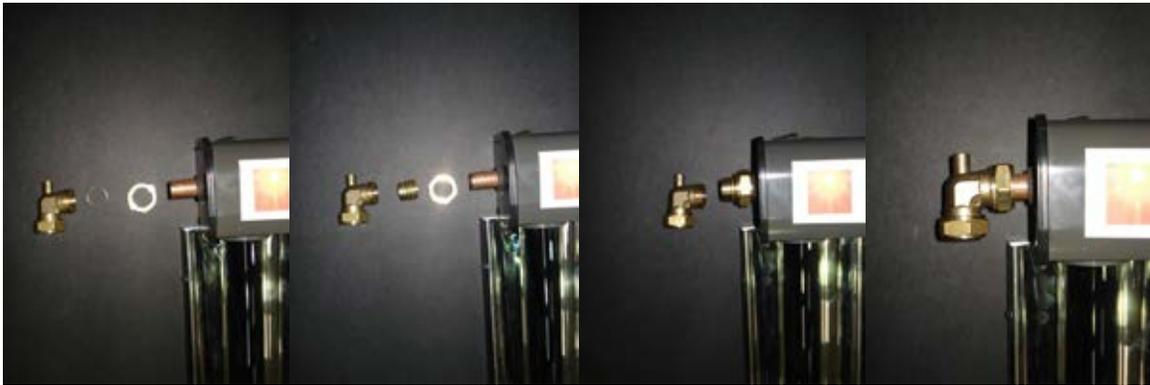
**Ilustración 71. Conexión hidráulica entre captadores CPC (1)**
