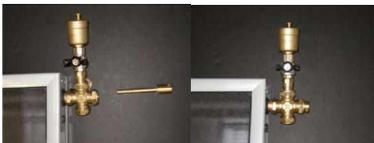
**Ilustración 67. Conexión hidráulica entre captadores planos (4)**
