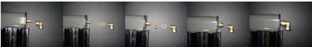
**Ilustración 73. Conexión hidráulica entre captadores CPC (3)**
